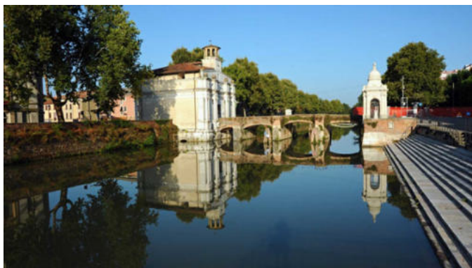
Fig. 12 - La porta e la scalinata del Portello oggi
